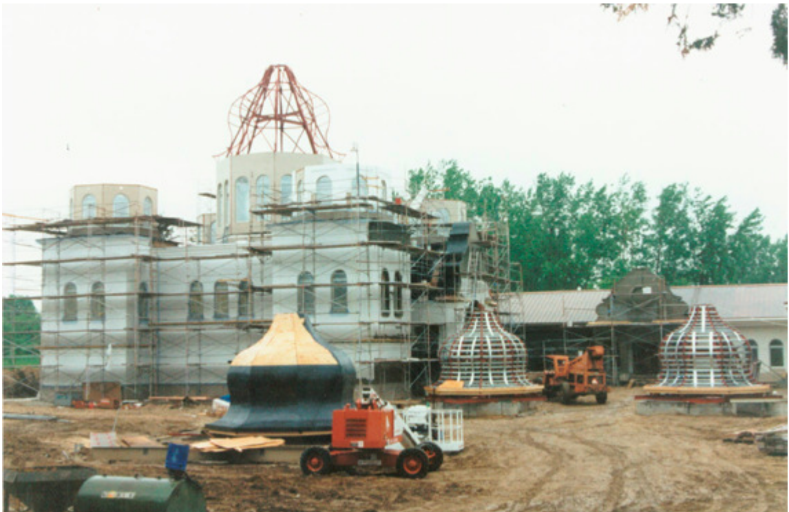
The cupolas were formed on site and covered by several layers of materials as specified by the architect and building contractors. Куполи були зформовані на місці будування і покриті кількома пластами матеріалів визначених архітектором та будівельними контракторами.
