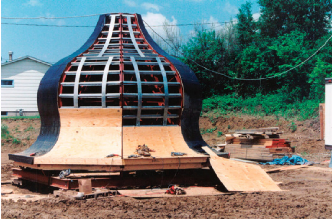
Details of one of the five cupola's formation. Детелі формування одного з п'яти куполів.
